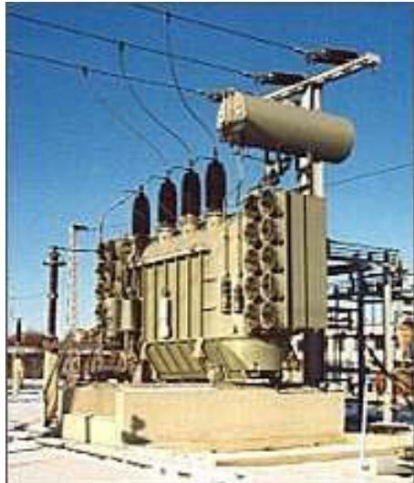
Toto napětí se transformuje na velmi vysoké napětí (vvn) – 220 kV nebo 400 kV, pro mezistátní přenos – 750 kV nebo 1 MV.
